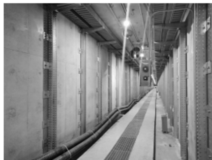
图 3 电缆隧道环境
